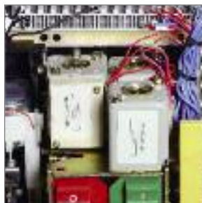
Независимый расцепитель, минимальный расцепитель и катушка включения
